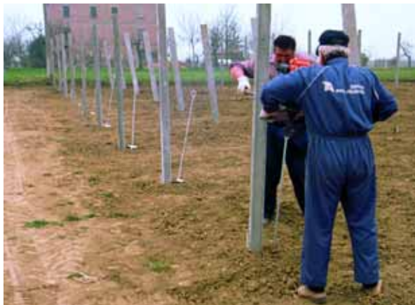
Interramento di ancore a vite.
