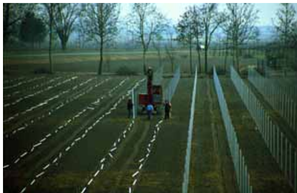
Interramento pali profilati.
